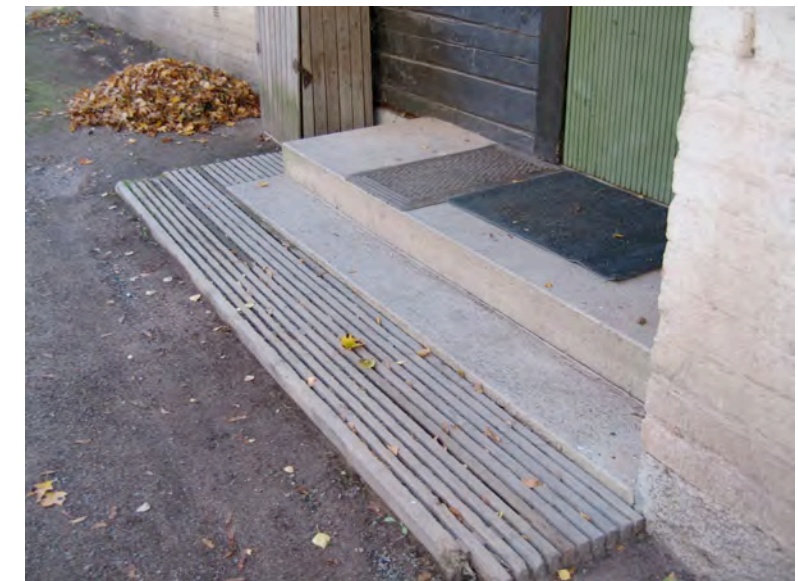
pääsisäänkäynnin jalkasäleikkö
