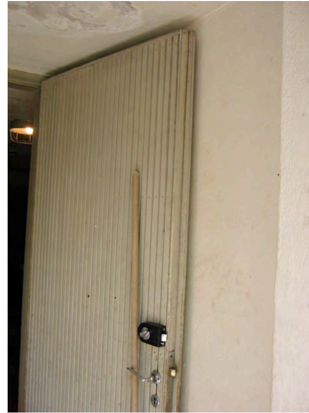
Porrashallin tuulikaapin ovi
